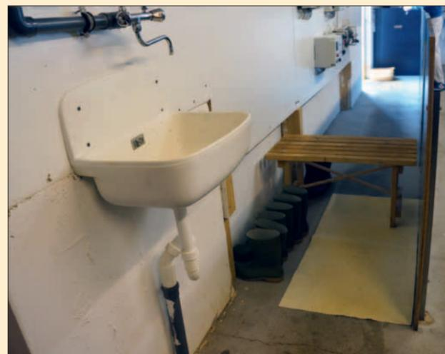
Abbildung 6: Einfache Umsetzung einer Hygieneschleuse, in der Schuhe desinfiziert, Schuhe gewechselt und die Hände gewaschen werden können
