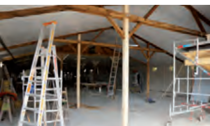
Amplia renovación de las granjas de Cuxhaven (fuente: archivo de LTZ)
